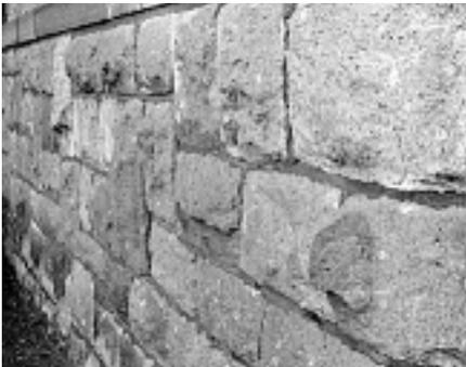
Dieses hatte folgenden Unterschied: Die Geraden, also die Lagerfugen, durften nur eine maximale Länge von 1,25 m haben. Die Bruchsteine durften auch hochkant versetzt werden, und der kleinste Bossenstein musste mindestens 8 mal 8 cm groß sein. Die Bossensteine waren besonders zugehauene Steine, an deren sichtbaren Seite jedoch die Wölbung des Steines belassen wurde.
